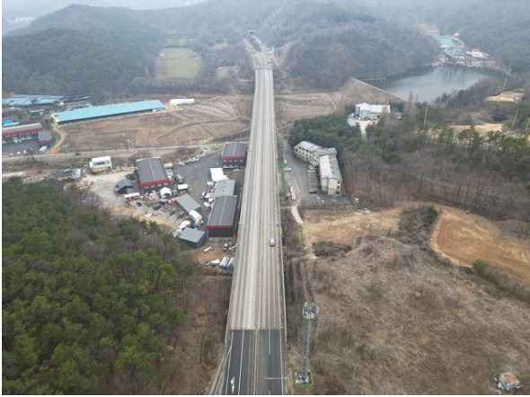
교량 상부 전경
