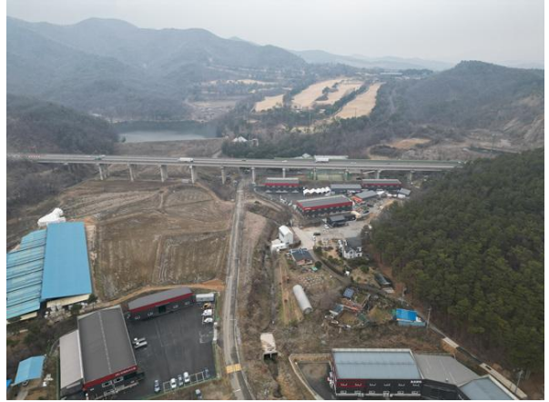
교량 측면 전경
