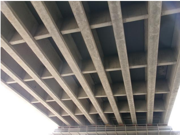
바닥판 하면 및 거더 전경
